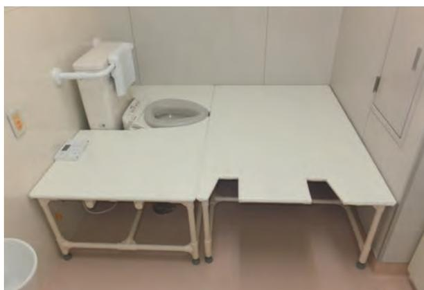
下半身麻痺の方など、移乗が大変で座位が安定しない方には大きなステージを製作します。車いすからステージに移乗する際に、タイヤ除けの切欠きをつけてあるので車いすをより近づけて移乗ができるようにしています。
