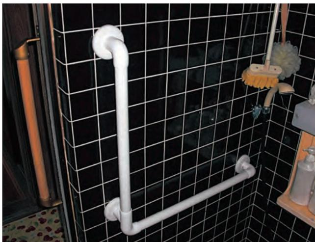
99-32-01 出入口の段差の上り下りを補助し、シャワーまでの動線上に横手すりを取り付けました。
