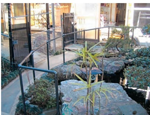
フリー支柱ジョイント（ECA-5028D）を使用し、庭の形状に合わせて施工しています。 61-34-03
