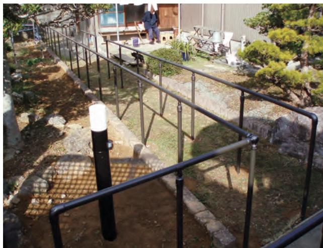
門から家屋まで両サイドに手すりを施工した事例です。体格に合わせた幅で取り付けています。 61-34-02
