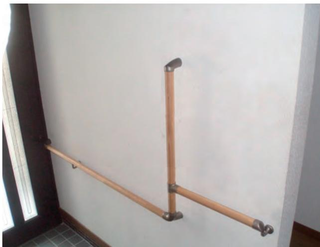
99-22-01 縦手すりと横手すりを組み合わせて構築することによって移動から段差の上り下りをサポートします。
