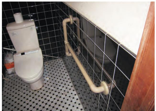
より滑りにくい、エラストマー樹脂被覆の手すりパイプを使用して取り付けることができます。 99-29-04
