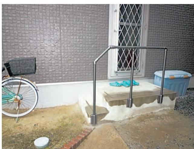
壁受けスタンド（EC-5006H）を使用することによって歩行幅を確保した手すりの施工が可能になります。 11-34-04
