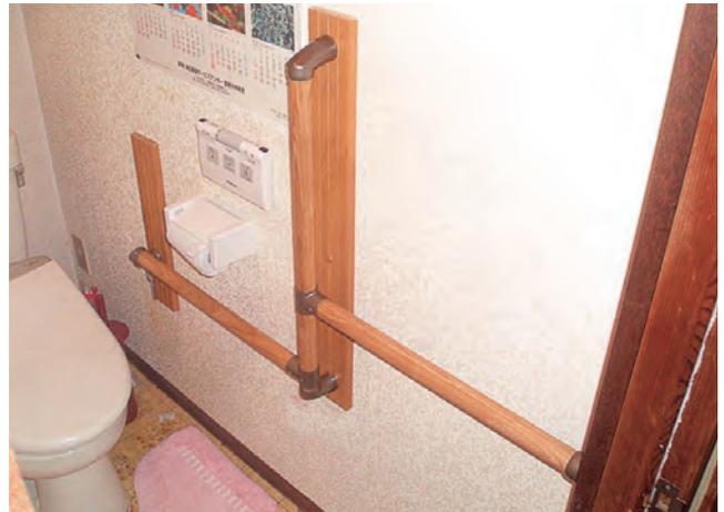
出入口から便座までの歩行補助と立ち座りを連続手すりで補助します。 99-29-02
