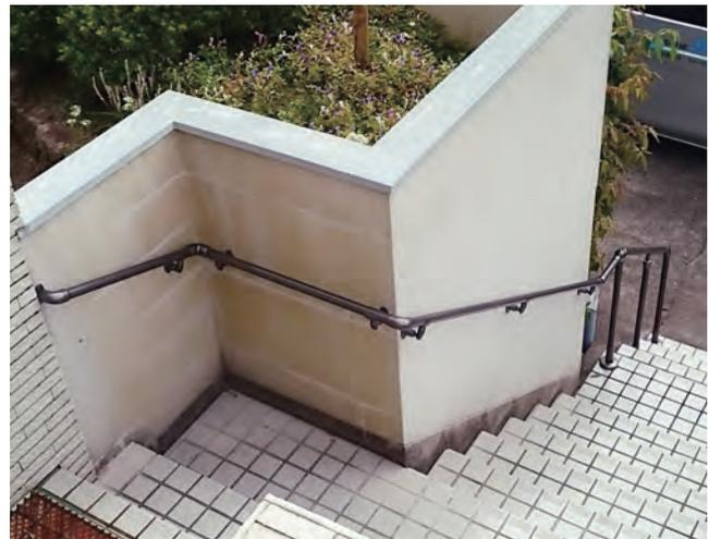
金具を組み合わせることで地面からの立ち上げ手すりや壁付け手すりを連続して構築できます。 71-35-04
