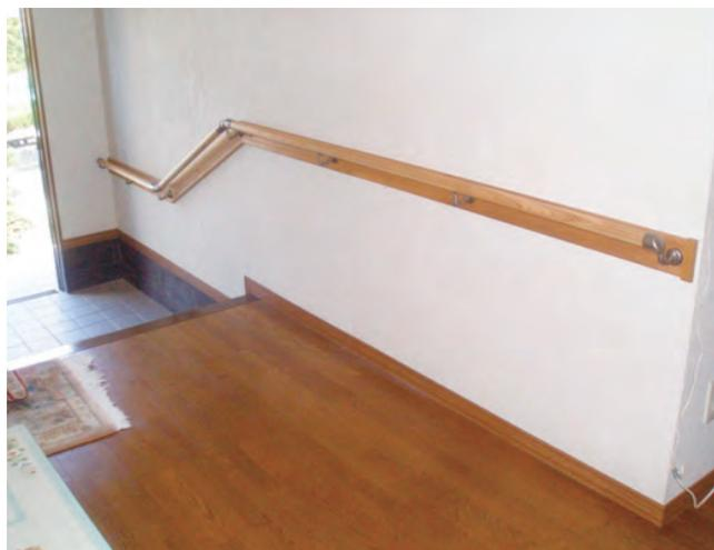
99-22-02 玄関入口からの段差を連続手すりで構築していくとより安心してご利用いただけます。
