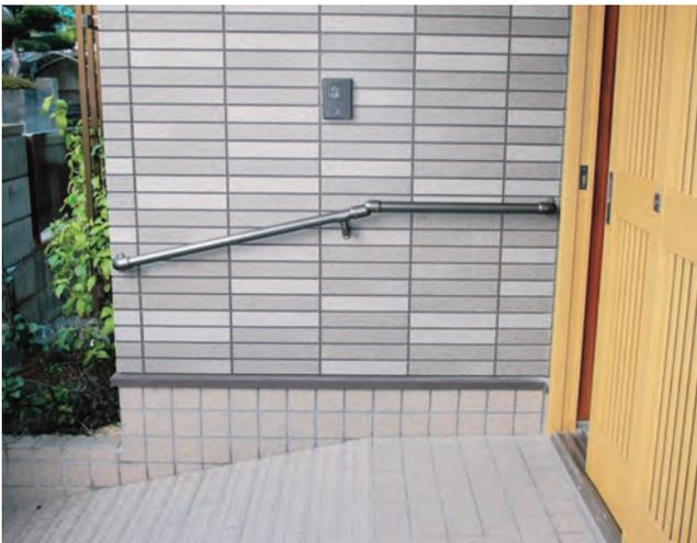
玄関前のスロープからポーチ部分まで地面に合わせて手すりを施工してあります。 61-35-03
