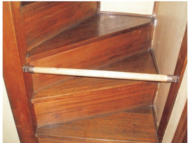
着脱手すりを使用すれば、通りたい時だけ取り外す
