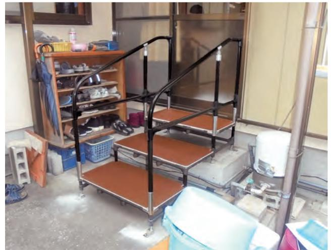
掃出し窓前の段差と配管を覆うようにステップ台を製作しました。蹴上げの高さが低くなり、安全になりました。 71-19-04
