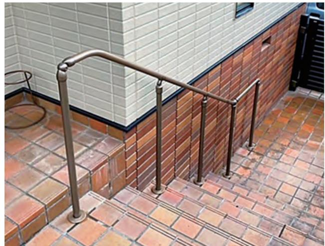
オーダーの曲げパイプ(SC6Y)を使えば、見た目がすっきりしていて使いやすい手すりを施工できます。 51-35-06
