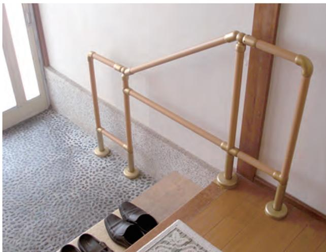
51-22-03 壁面に手すりが取り付けられない場合は床から立ち上げの手すりを構築できます。
