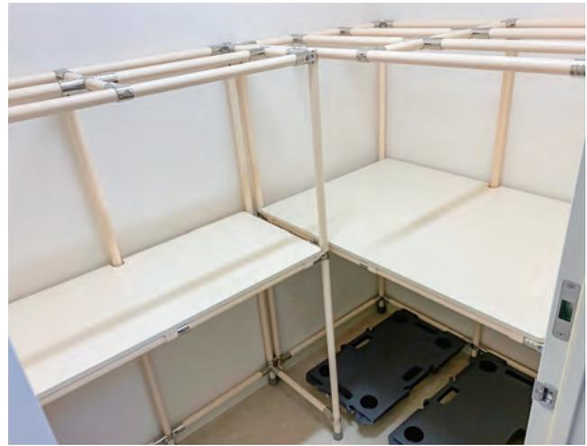
現場サイズに合わせて収納棚を製作いたします。荷物を床に置かないようにミニポリトラ(台車)をセット。 45-49-02
