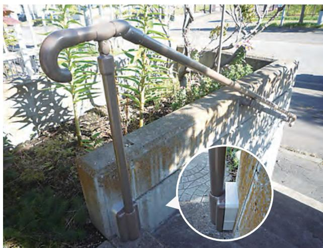
壁受けスタンドスペーサーと壁付けブラケットを組み合わせて施工することで、歩行幅を広く確保できます。 03-34-06
