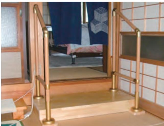
99-22-05 踏み台だけでは転落のリスクもあるので手すりを付けると、より安心して上り下りができます。
