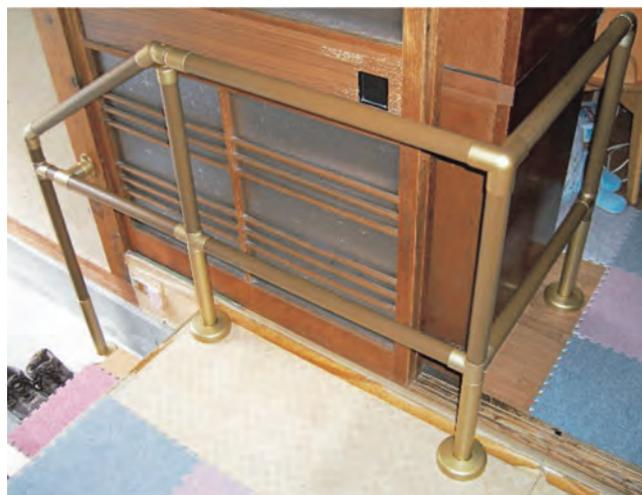
99-22-06 段差を乗り越えてからも一連で動線に沿って手すりを構築すると、より安全にご利用いただけます。
