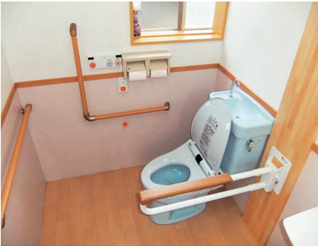
可動式手すりと壁付手すりを併用して、ご利用者様の安全と介助のサポートをします。 99-43-01
