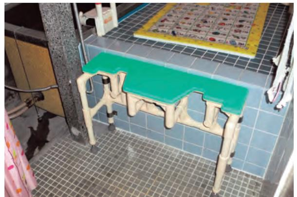
既存バスステージにより近づいて移乗するために補助台を製作。金具で固定し動かないようにしています。 27-12-03
