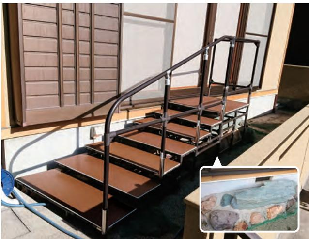
靴脱ぎ石を避けるように手すり付ステップ台を製作しました。ご利用者様に合わせて蹴上げ高さを低くしています。 45-19-05
