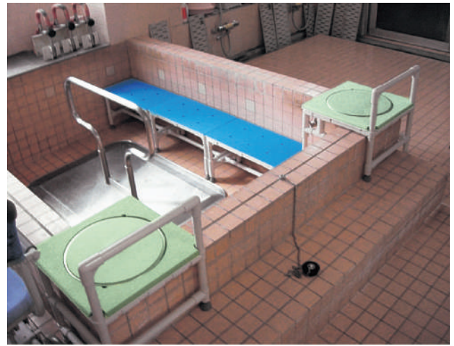
71-43-02 浴そう出入りに入浴台、浴そう内での座位保持に浴そう内たちあっぷ、浴そう内ベンチを設置しました。
