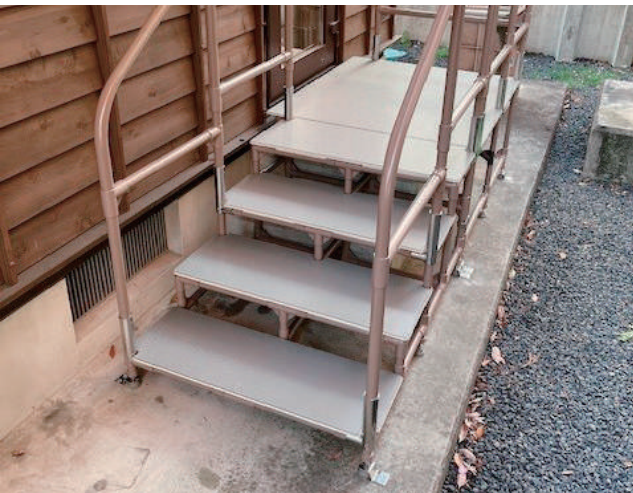
既存のコンクリート階段に被せるように手すり付ステップ台を設置しました。1段の段差を小さくして、楽に上り下りができるようにしました。05-19-05
