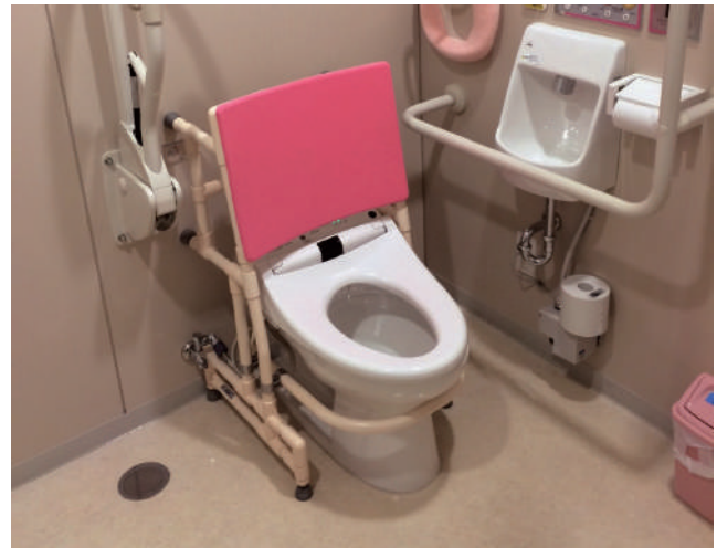
座位が安定せず後ろにのけぞって、ひっくり返ってしまう方のために背もたれを製作しました。 05-47-02
