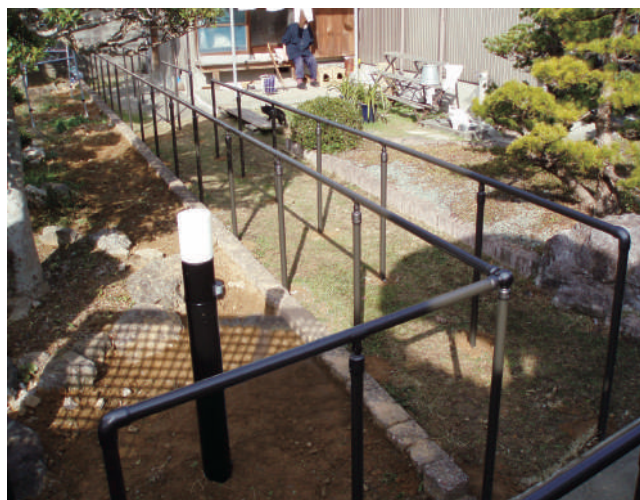
門から家屋まで両サイドに手すりを施工した事例です。 体格に合わせた幅で取り付けています。 61-38-02
