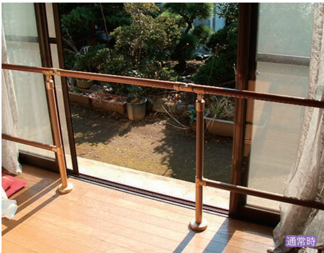
はね上げ手すり金具を使用すれば、部屋の前の扉や庭への 出入りを妨げずに連続した横手すりを取り付けられます。
