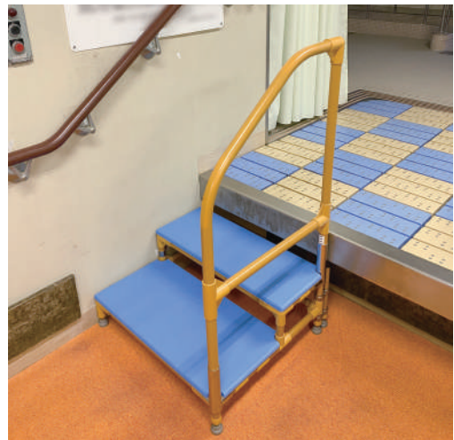
脱衣室の段差解消のために手すり付ステップ台を導入し、安全に昇降ができるようになりました。 45-45-06
