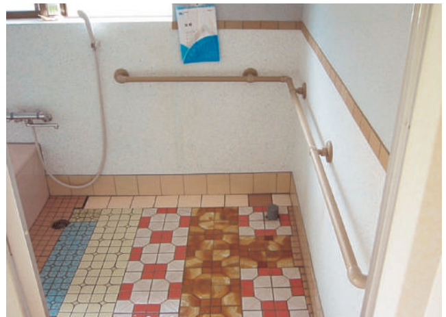
広い洗い場なので洗い場全体の移動を補助するために連続した長い横手すりを取り付けました。 71-32-04
