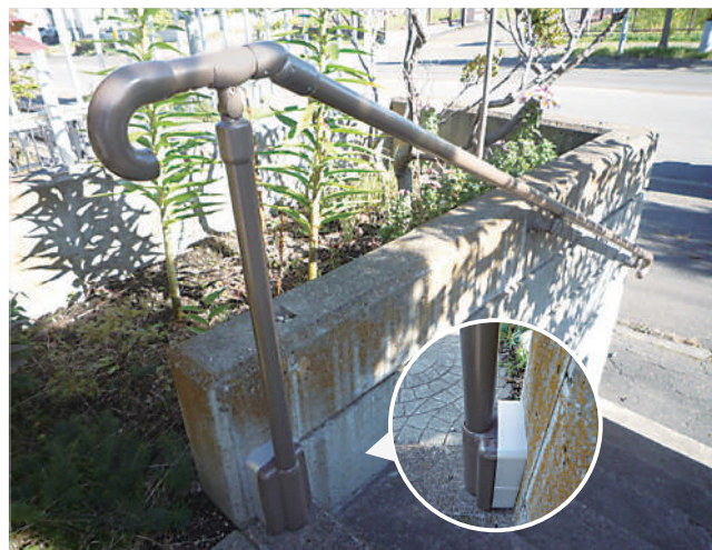
壁受けスタンド Spacer と壁付けブラケットを組み 合わせて施工することで、歩行幅を広く確保できます。 03-38-06
