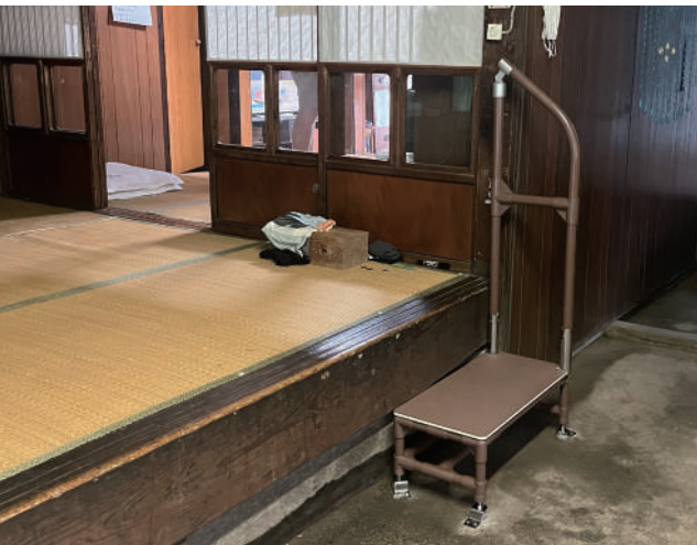
土間から部屋への上り下り用に設置しました。通路の71-19-03 邪魔にならないようにコンパクトな形状にしました。
