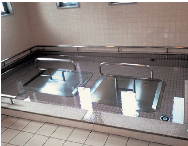
05-43-05 浴そう中央に手すりがなく、浴そう内での移動が不安だったので置くだけの浴そう内たちあっぷを導入しました。
