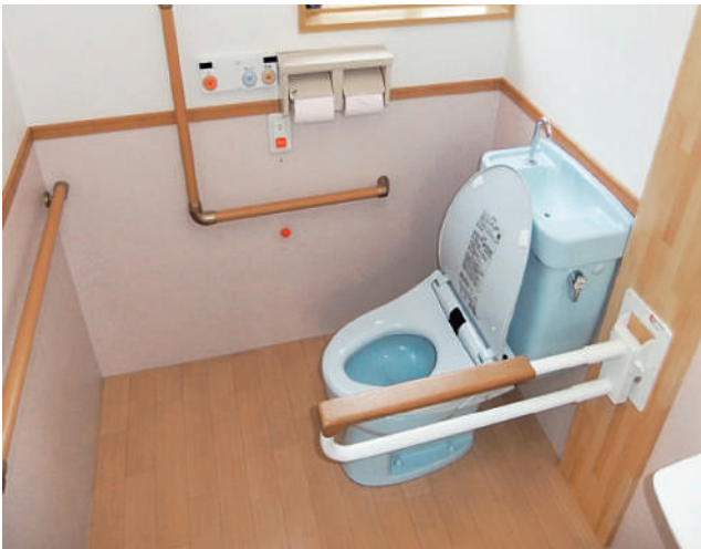
可動式手すりと壁付手すりを併用して、ご利用者様の安全と介助のサポートをします。 99-47-01
