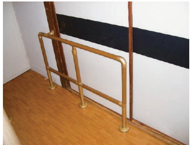
ふすまの前などは床から立ち上げ式の手すりを取り付けできます。柱に補強を取るとより強くなります。 99-26-04
