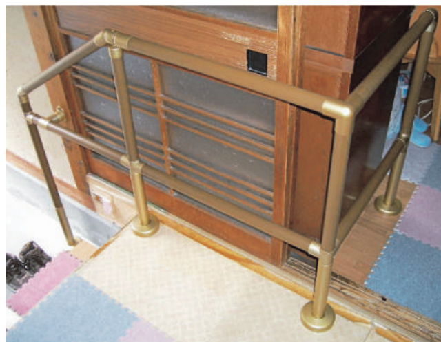
段差を乗り越えてからも一連で動線に沿って手すりを構築すると、より安全にご利用いただけます。 99-22-06
