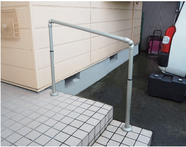
淡色の壁に合うように、シャンパンゴールド色の手すりでも施工しました。 91-39-01
