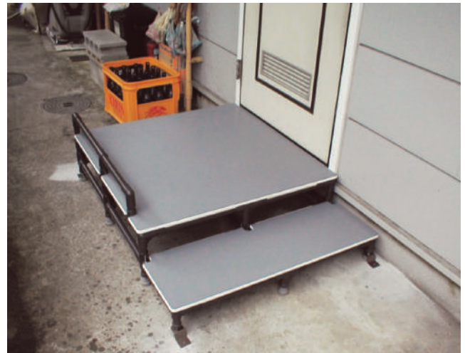
扉を開け閉めしやすい形状としました。アプローチの 仕方に応じて形状を提案いたします。 45-17-02
