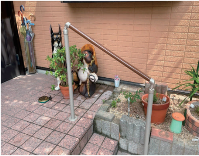
段差がある部分にワンポイントで手すりを構築しました。
