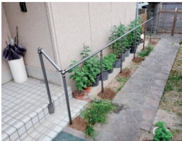
上側の支柱は階段の蹴込みに壁受けスタンドで固定し、 玄関前スペースを広く取るようにしました。 71-38-05
