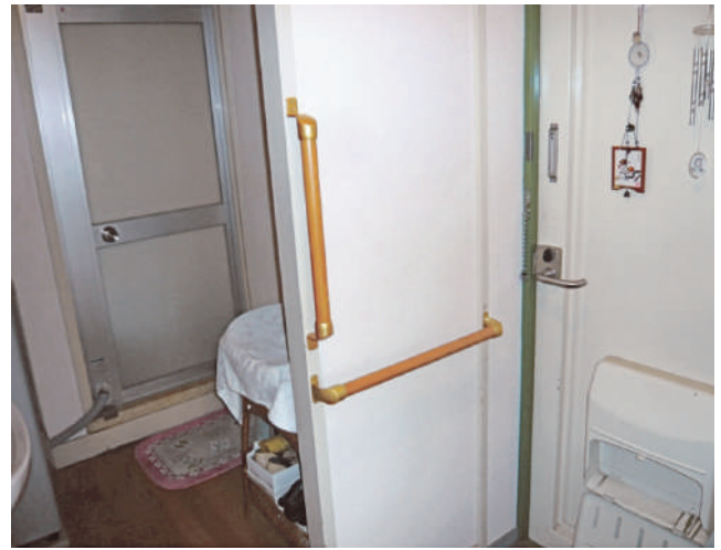
壁の状況に合わせてスリムタイプの金具を使用して手すりを取付けできます。 99-26-02
