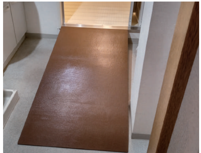
03-23-04 浴室へ続くならかなスロープを設置しました。
