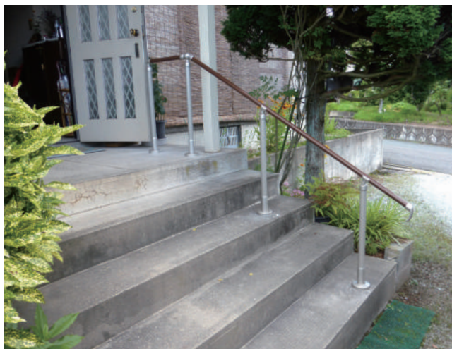
最後の1段まで安全に下りられるように下側は長めに手すりを伸ばしています。 05-36-05
