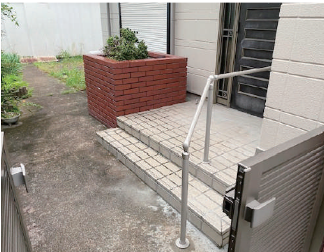
玄関から門までの動線に合わせて斜めの手すりを構築しました。
