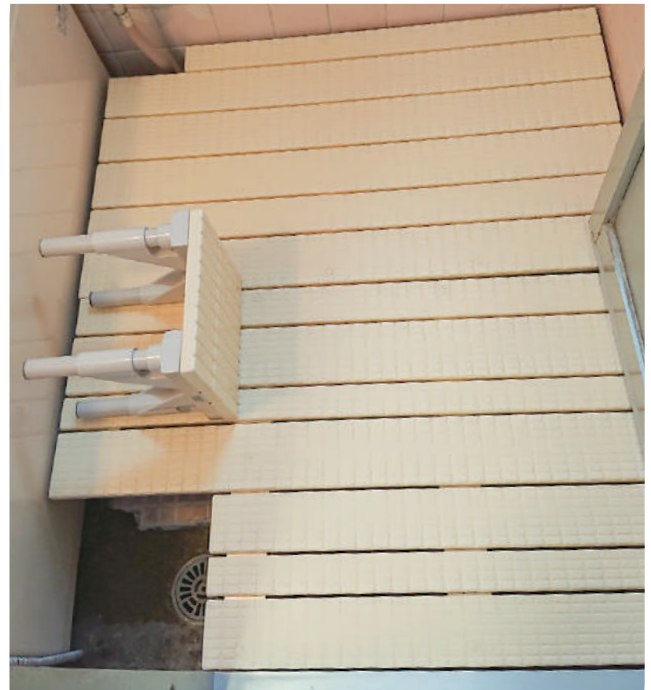
排水口のメンテナンス用に小さなすのこを組み合わせました。 45-09-02
