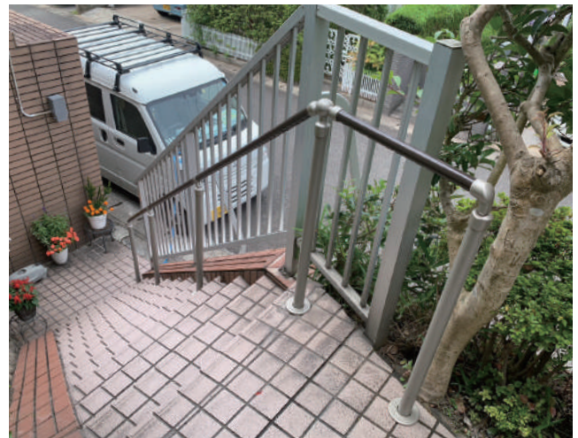
長い階段を安全に上り下りできるように手すりを設置しました。
