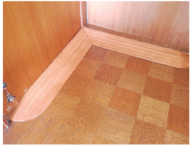
11-23-02 出入口が2方向にあるので角入隅加工をした、L型のスロープを製作し、設置しました。
