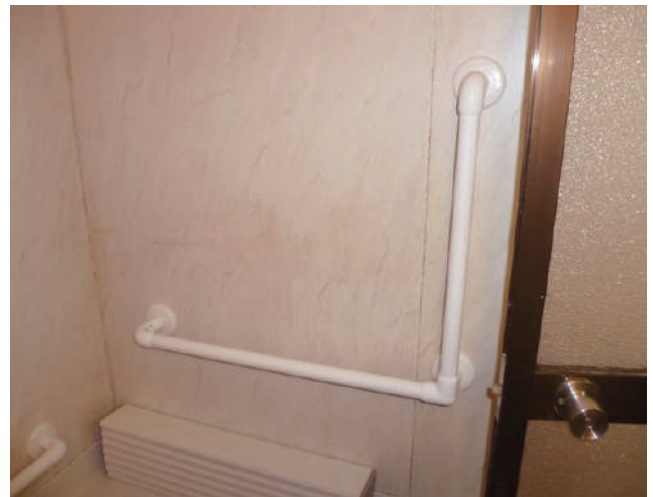
ユニットバスでもパネルの強度があり、ユニットバス用ファスナー（ウエルナット）を使えば施工可能です。 45-33-04
