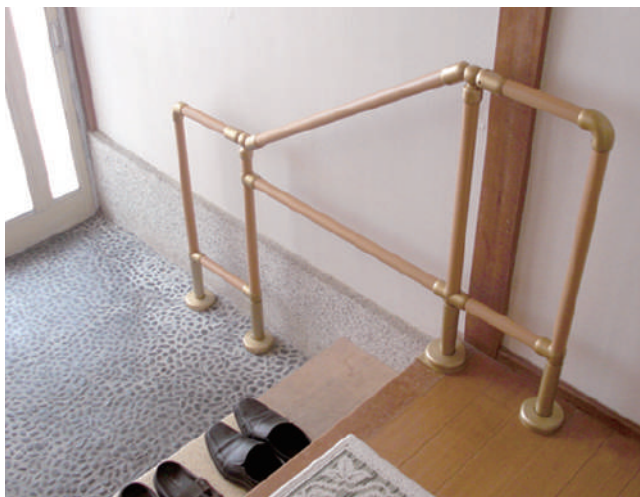
壁面に手すりが取り付けられない場合は床から立ち上げの手すりを構築できます。 51-22-03
