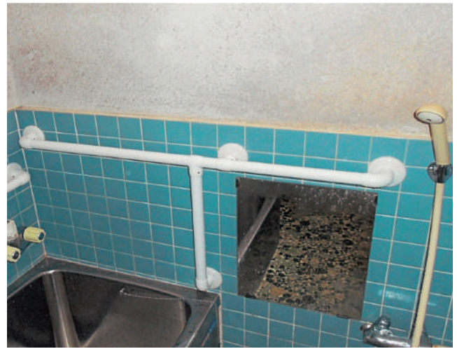
浴そうへのアプローチ、またぎ動作、立ち上がりを補助する形状としています。 51-33-02
