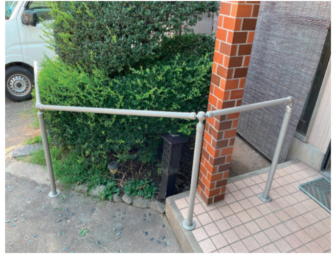
玄関から駐車場までの連続した手すりですべて安全に移動できます。
