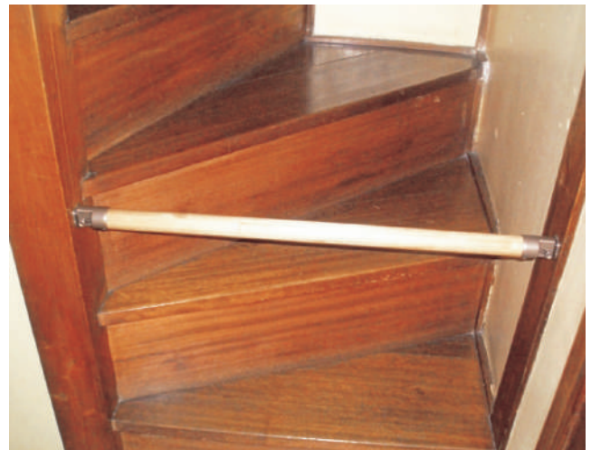
着脱手すりを使用すれば、通りたい時だけ取り外す ことができます。[注]
