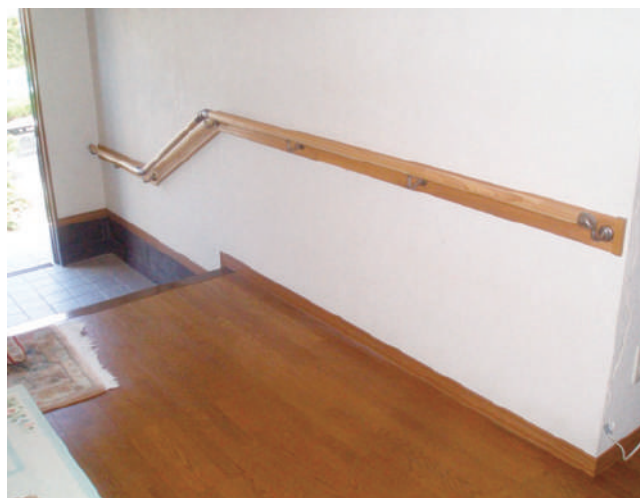
玄関入口からの段差を連続手すりで構築していくとより安心してご利用いただけます。 99-22-02
