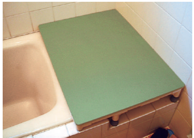
浴そうの縁に厚みがあり立位入浴が困難だったため、浴そうと壁の間の段差を埋める形で入浴台を製作しました。 25-05-05
