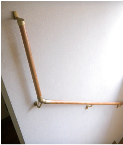
階段では連続した手すりの取付けをお勧めします。 この事例では最上段で身体を支えられるように手すりを縦に延長しました。
