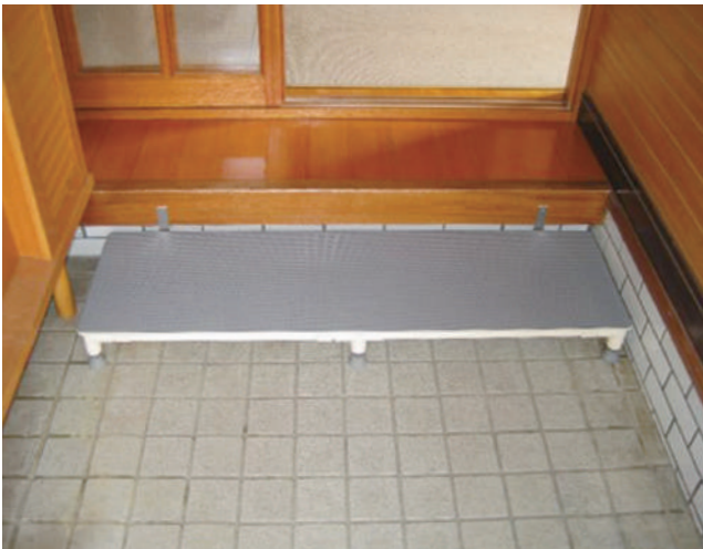
玄関での動作が安全に行えるように玄関の幅いっぱいに、 天板面積の大きいステップ台を設置しました。 03-17-01
