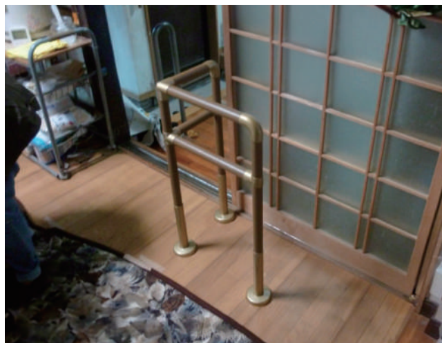
動線に合わせてL型手すりを設置しました。 71-22-04
