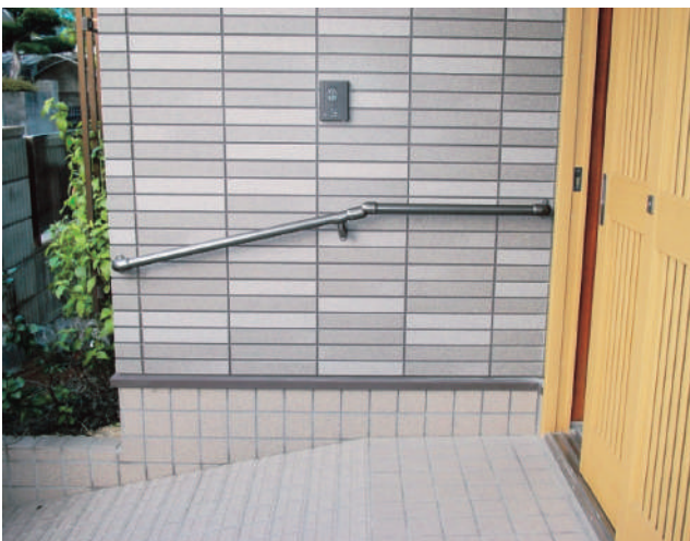
玄関前のスロープからポーチ部分まで地面に合わせて手すりを施工してあります。 61-39-03
