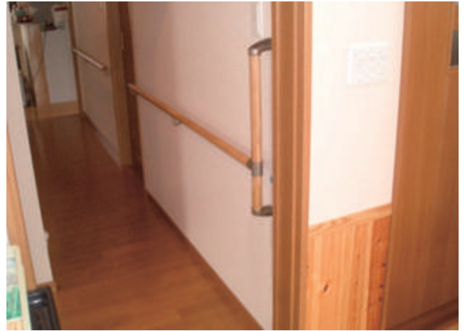
縦手すりです扉を開ける動作を補助します。横手すりと連続させることで、より安全にご利用いただけます。 99-25-02
