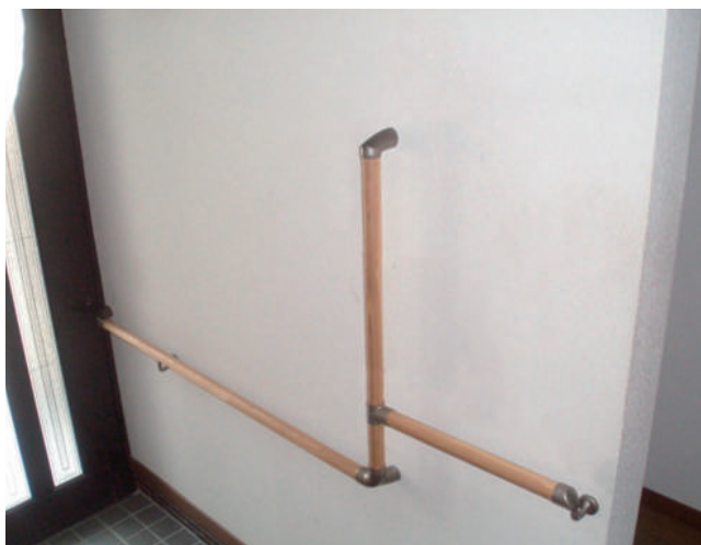
縦手すりと横手すりを組み合わせて構築することによって移動から段差の上り下りをサポートします。 99-22-01
