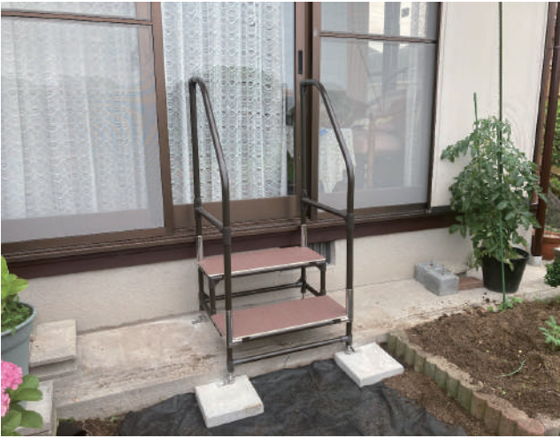
掃き出し窓の段差に合わせて手すり付ステップ台を設置。71-19-01 犬走りでは幅が足りなかったので、下側は設置面も新たに整備しています。
