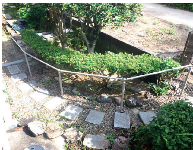
動線に沿わせてアーチ状の手すりを構築しました。 65-36-03
