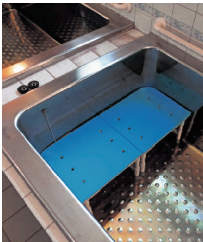
45-42-05 浴そうの片面に浴そう内ベンチを設置しました。
