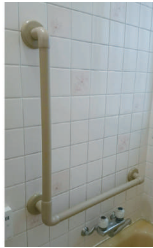
転倒リスクの高い出入口および浴そうへの出入り用にワンポイントで手すりを設置しました。 45-33-01
