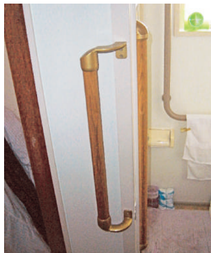
オフセットタイプでどちらからでも握れるようになっています。 99-26-06
