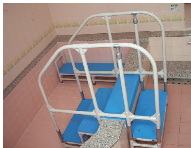
浴そうのまたぎを安全に行うため、手すり付ステップ台で上り下りができるようにしました。 25-44-04
