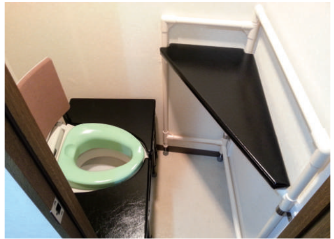
便座と壁との空間を移乗台で補い、前方に支えになる台を設置して姿勢が安定して移乗ができるようにしました。 11-14-02
