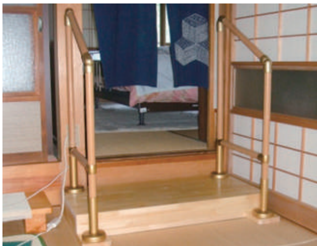
踏み台だけでは転落のリスクもあるので手すりを付けると、より安心して上り下りができます。 99-22-05
