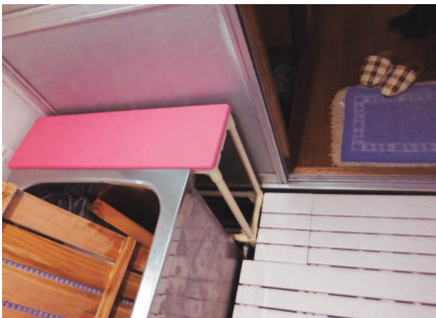
浴そうと引き戸の間のスペースを利用して入浴台を製作。安心して座位入浴ができるようになりました。 45-05-04
