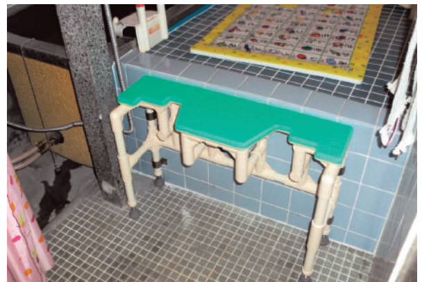
既存バスステージにより近づいて移乗するために補助台を製作。金具で固定し動かないようにしています。
