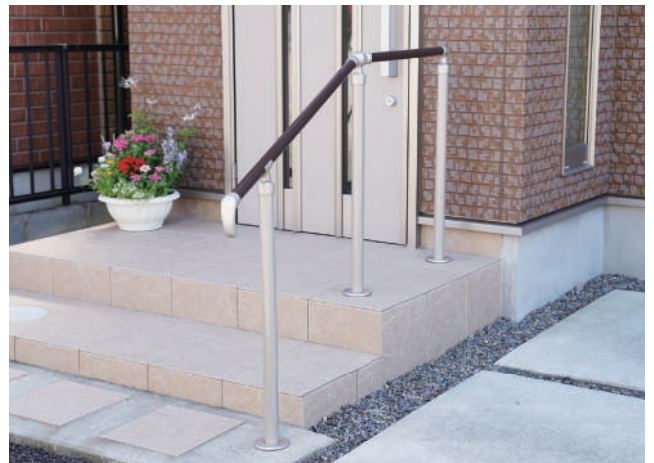
外観になじむビターブラウン色で手すりを取り付けました。 47-34-04
