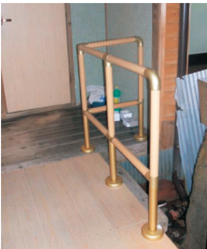
L字型に手すりを構築して転落防止にもなりました。 45-26-05
