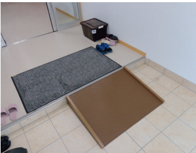
27-23-05 脱輪防止枠を付けた土足マット木製スロープです。屋外から車いすで上り下りしても安心です。
