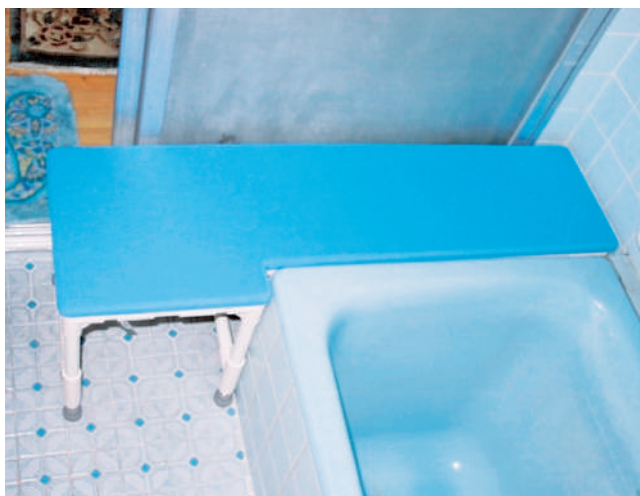
99-06-01 浴そうの横のすき間を利用して入浴台を製作。広いスペースを作ることで浴そうへの出入りをしやすくしました。
