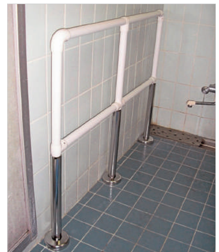
浴室手すりでも壁に強度がない場合、床から立ち上げが可能です。 71-33-07
