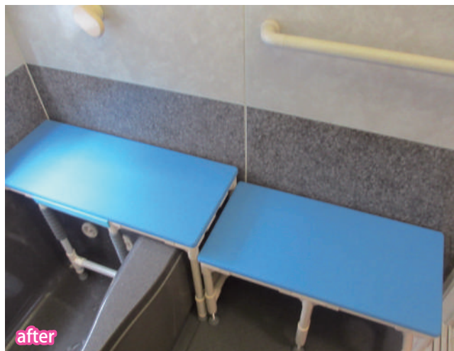
after 右側の低い台は車いすからの移乗のため、高さを車いすの座面の位置に合わせています。
