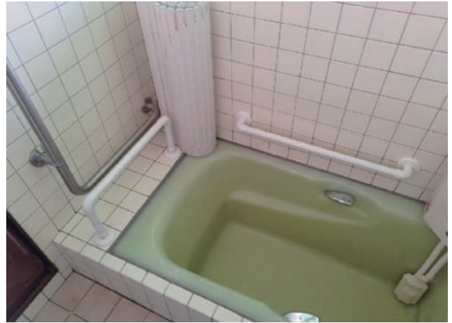
浴そう横のスペースにエンドベース(EBT-103B)を用いてI型手すりを立ち上げました。 71-32-02
