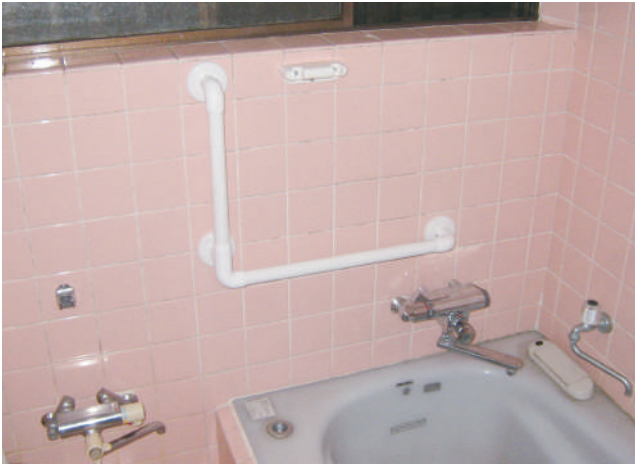
縦手すりです浴そうをまたぐ動作を、横手すりです浴そう内の移動をサポートします。 61-32-01
