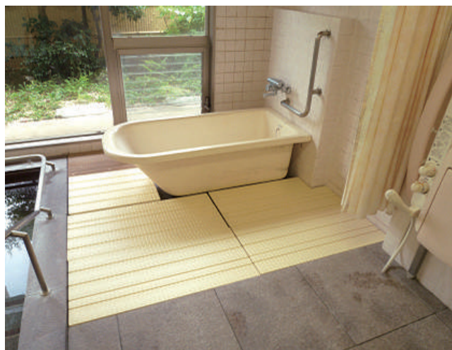
25-42-02 据え置き式浴そうの周りの段差解消し、またぎ動作を行いやすきするためにフォーアクセスすのこを導入しました。
