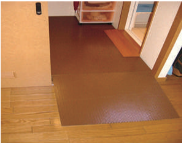
99-23-03 スロープと段差解消台を併用して、大きな段差を2段階で上り下りできるようにしました。
