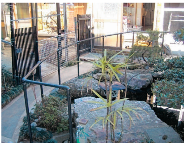
フリー支柱ジョイント（ECA-5028D）を使用し、庭の 形状に合わせて施工しています。 61-38-03
