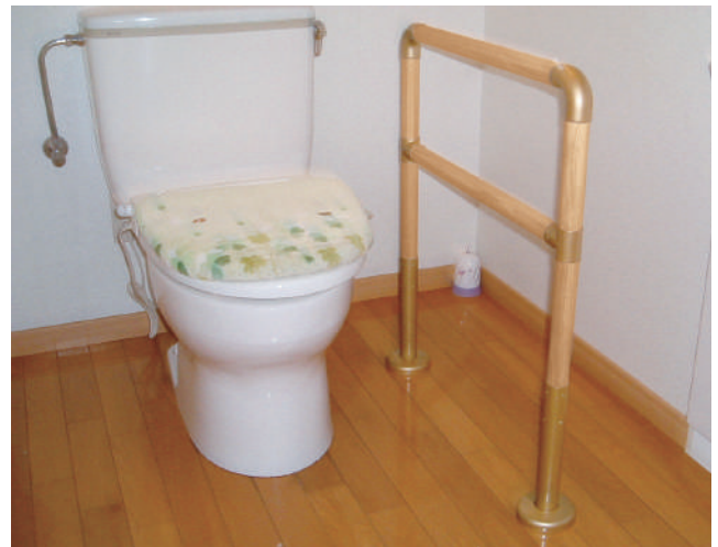
便器から壁までの距離が離れている場合は床からの立ち上げ手すりですサポートする方法もあります。 99-31-03
