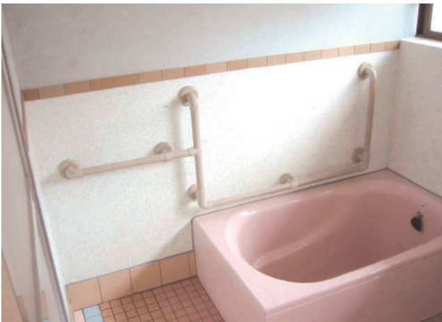
出入口からの歩行補助とまたぎ動作、入浴中の座位保持、立ち上がりまでを補助する手すりです。 71-32-03
