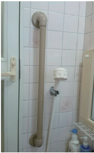
転倒リスクの高い出入口および浴そうへの出入り用にワンポイントで手すりを設置しました。 45-33-01
