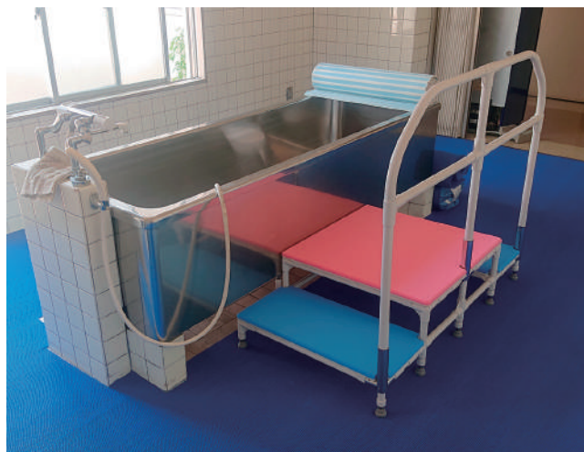
浴そうへ出入りするためのステップ台を設置しました。踏み板の色分けをすることでご利用者様の視認性に配慮しました。 71-44-02
