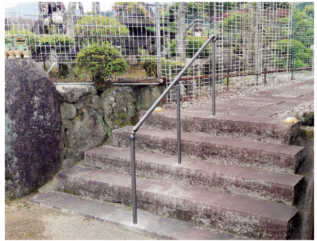
中央に手すりを設置することで、上り下りともに利き手で握ることができます。 71-39-02
