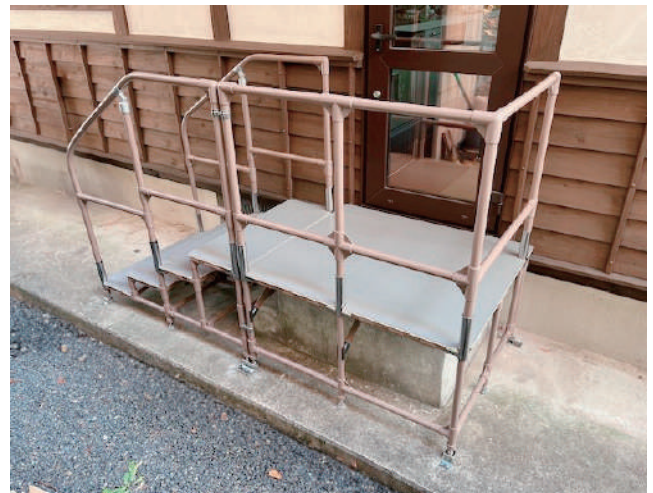
既存のコンクリート階段に被せるように手すり付ステップ台を設置しました。1段の段差を小さくして、楽に上り下りができるようにしました。05-19-05
