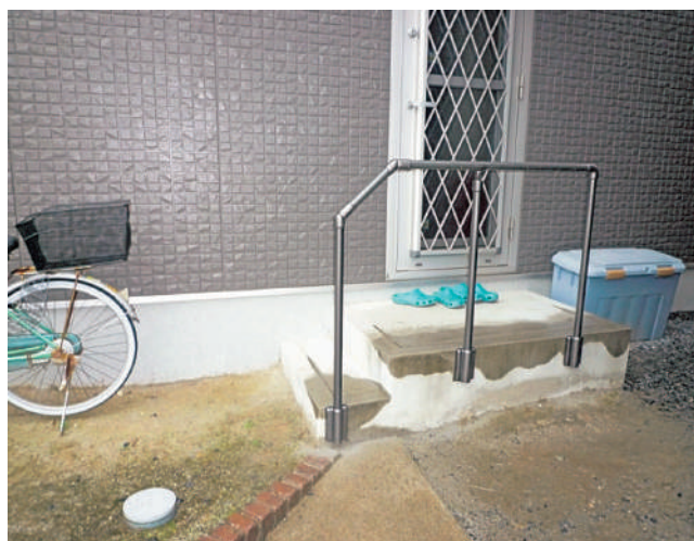
壁受けスタンド（EC-5006H）を使用することによって 歩行幅を確保した手すりの施工が可能になります。 11-38-04
