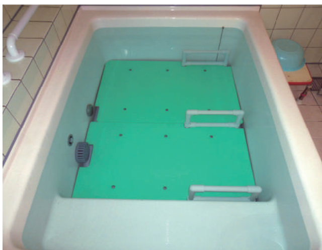
底上げをし、さらに座位を保持できるようにするため、手すりを付けて体を支えられるようにしました。 25-44-03
